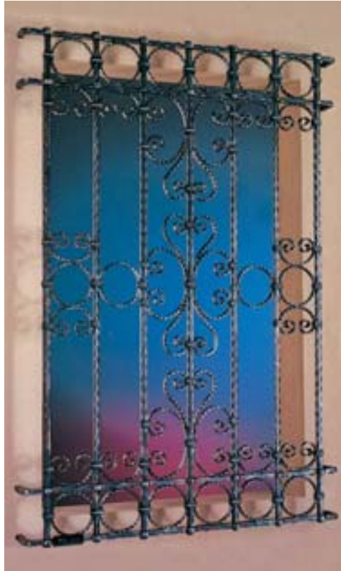
INFERRIATA COMPOSTA DA PALETTI FORGIATI CON DECORAZIONE WINDOW GRATE WITH FORGED BARS AND DECORS
